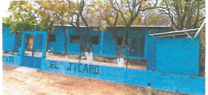
Foto 4: Mantenimiento de puertas, cambio de chapas, mantenimiento de estructura metálica en escuela, colocación de lamina nueva, cambio de techo de baño.
