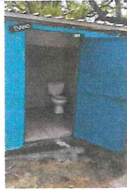
Foto 2: Colocación de costanera, lámina nueva y azulejo en el baño.
