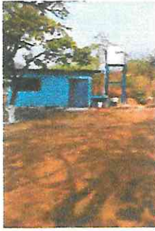
Foto 1: Instalación de tanque elevado.
