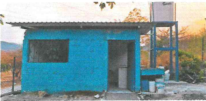
Foto 3: Cambio de techo.
